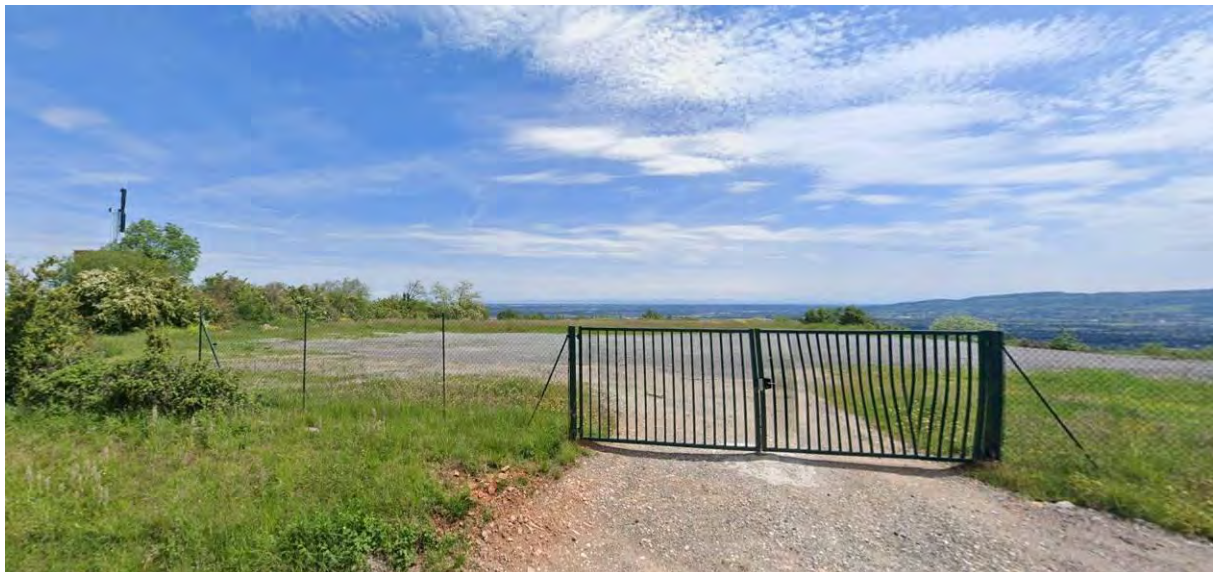
Vue 5 : vue depuis le chemin de Montézain, à l'Ouest du site. On notera la frange végétale importante au Nord du site qui masque la tour Chappe.
