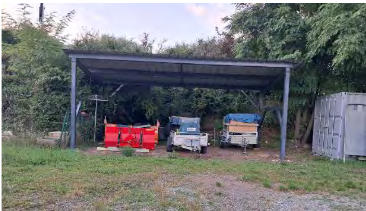
Vue 3 : espace de stockage existant qui abrite actuellement une partie du matériel communal.
